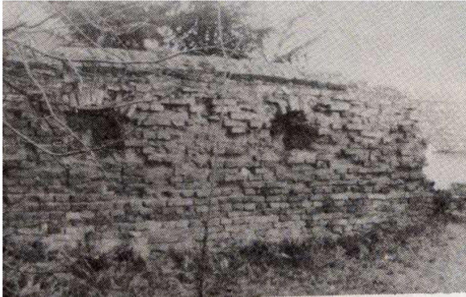
6. ábra Az 1944. október 17-ei belövésektől megsérült templomerőd falának egy szakasza. Forrás: Diószegi Lajos: Fejezetek Hajdúszovát történetéből és néprajzából.
